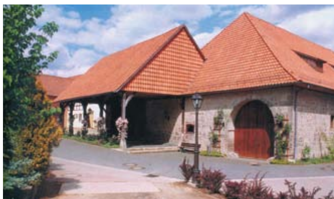
Dorferneuerung: Sanierung der historischen Zehntscheune, Freden / Niedersachsen
