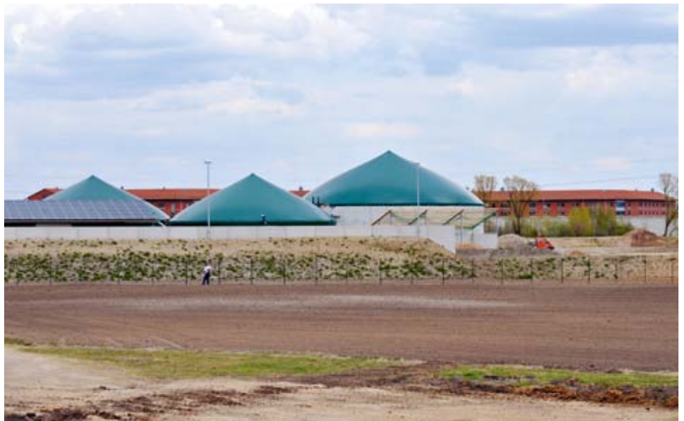
Die Biogasanlage der Mükro Bioenergie GmbH & Co. KG vor der JVA
