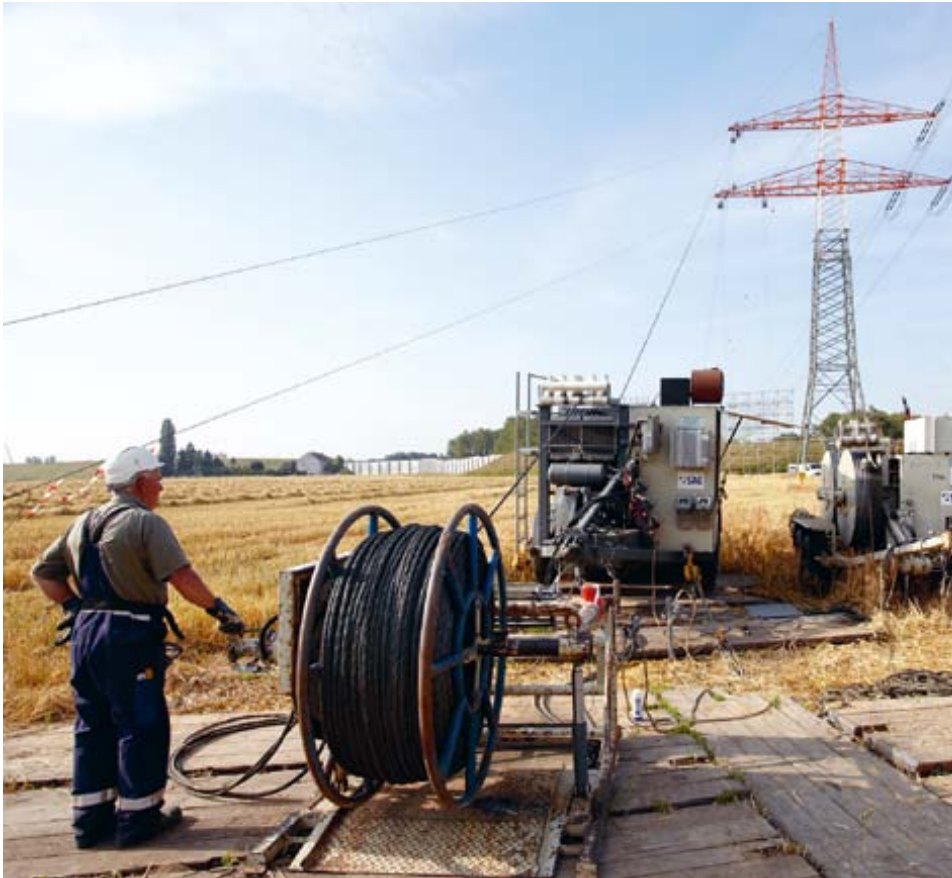
Umbeseilung von Stromleitungen
