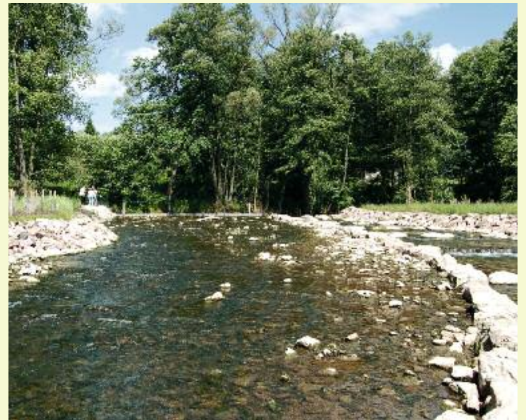
Wehr F07 in Stadtlengsfeld „Sohlgleite mit Beckenstruktur“
