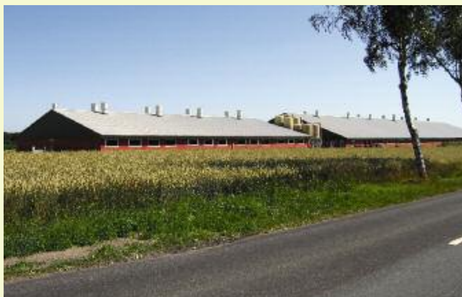
Neubau: Sauenstall für 750 Sauen und Ferkelaufzucht
