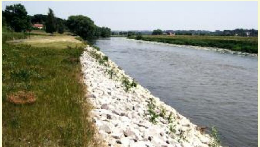
Erosionsschutz an der Freiburger Mulde
