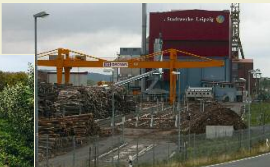
Biomassekraftwerk der Stadtwerke Leipzig
