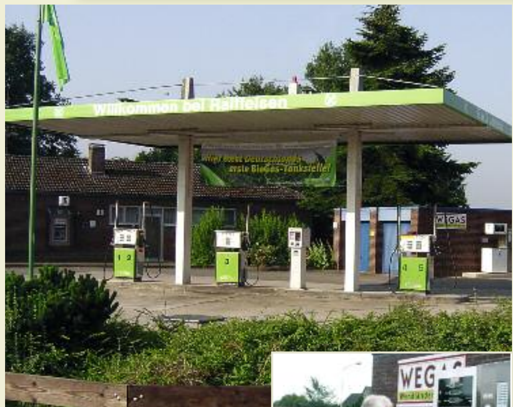
Erste Biogastankstelle in Deutschland
