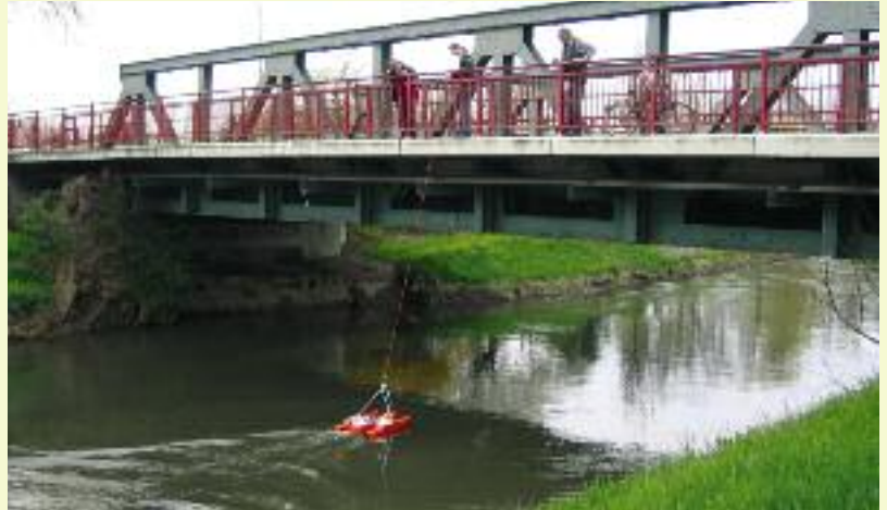
Spezialtechnik im Einsatz
