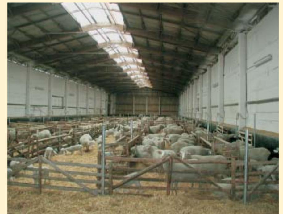
Abb. 1: Ehemaliger Bergeraum, umgebaut zum Mutterschafstall mit mobiler Bewirtschaftung für Fütterung und Entmistung; höhenverstellbarem, beheiztem Umlauftränkesystem; variablen Buchtengrößen; offenem Lichtfirst
