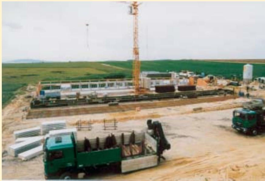
Abb. 2: Pilotprojekt: In Modulbauweise gestalteter Maststall
