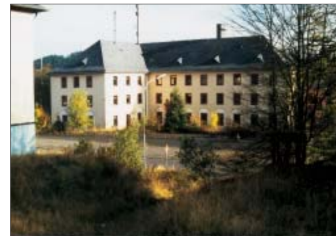
Kasernenkomplex in Bad Schwalbach
