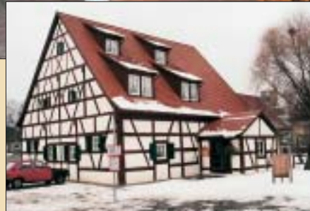
Umnutzung einer ehemaligen Zehntscheune in eine „Radlerscheune“ in Gutenstetten/Bayern
