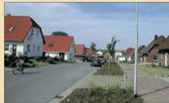
Gemeindeentwicklungsvorhaben „Herren Steinfeld“ bei Schwerin: Die Flächen wurden von der Landgesellschaft erworben, erschlossen, parzelliert und an Bauherren veräußert.
