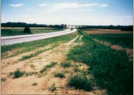
Baustelle der Bundesautobahn 20 - Verkehrsprojekt Deutsche Einheit: Für die Trasse und die erforderlichen Ausgleichsflächen wird von der Landgesellschaft der Grunderwerb auf dem Gebiet des Landes durchgeführt.
