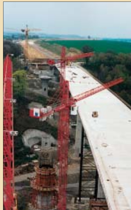
Termingerechter Grunderwerb ist für die Realisierung von Verkehrsprojekten eine wichtige Voraussetzung, so auch für die Erstellung der Brücke über das Triebischtal.
