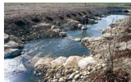
Gut sichtbar sind die Steinriegel zwischen den Einzelbecken, die neue Uferbepflanzung mit Schwarzerlen, Feldahorn, -ulmen und Eichen und im Hintergrund die neue Feldwegüberfahrt.
