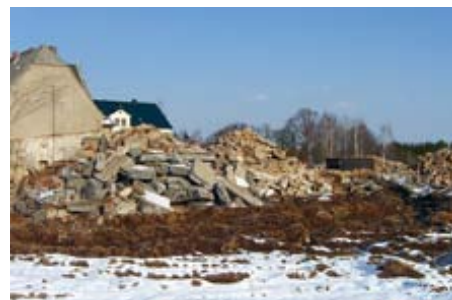
Vorher: Abriss der Gebäude Februar 2013
